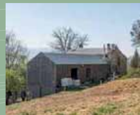
CÎTE « LE CRÊT DU LOUP » & BÂTIMENT AGRICOLE Claix
