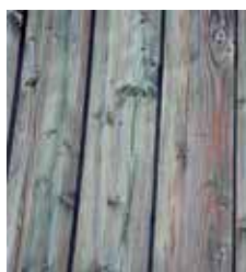
Bardage de Douglas autoclavé exposé 15 ans sur façade Ouest
