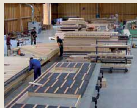
Panneaux de murs préfabriqués en atelier
