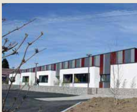
Maison médicale à Sainte-Sigolène (43) Architecte : W Architectes
