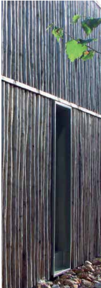
Revêtement extérieur réalisé en baliveaux de châtaignier refendus
