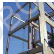
Structure bois poteaux poutres et murs en panneaux de bois massif contrecollé
