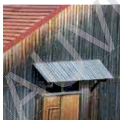
Différence d'aspect selon exposition et protection d'un bois sans finition mais durable (classe 3).
