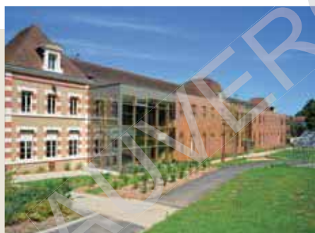
Extension école élémentaire Guyot-Dessaigne à Billom (63) Architectes : Bruhat et Bouchaudy
