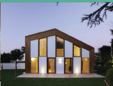
MAISON "LA CHAPELLE" à Lyon (69)
