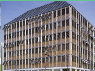
MAISON DE TERRITOIRE à Voiron (38)
