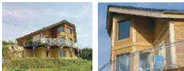
« LA GRANGE » À SAINT-BASILE (07) - Architecte : Marlier (07) - ©Marlier
