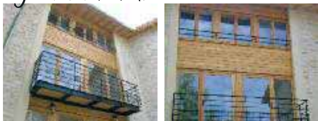
MAISON À HAUTECOURT-ROMANÈCHE (01) - Architecte : Philippe Arnaud (01) ©Philippe Arnaud
