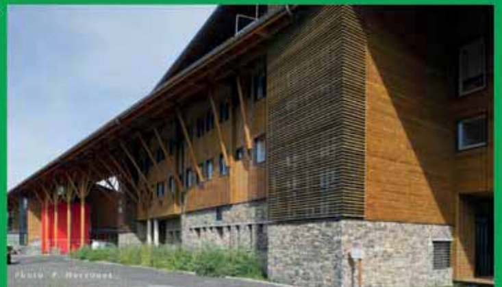
LYCÉE AGRICOLE D'YSSINGEAUX Architecte: Pierre Chomette Architecte associé: G. Miramand
